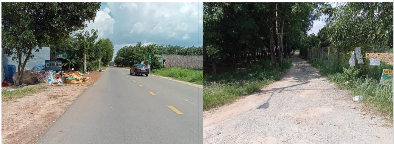
Hình 2: Đường ĐT.741-cầu Ông Lóc và đường bê tông
